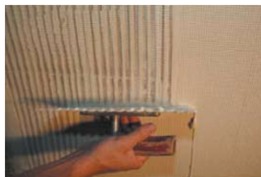
A ragasztó réteg elsimítása és glettelése
