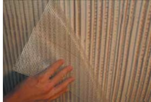
Üvegszálalás háló elhelyezése ragasztóba
